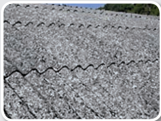
Lastre di copertura
